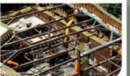
銀獎 屯門西部污水收集系統建造工程
